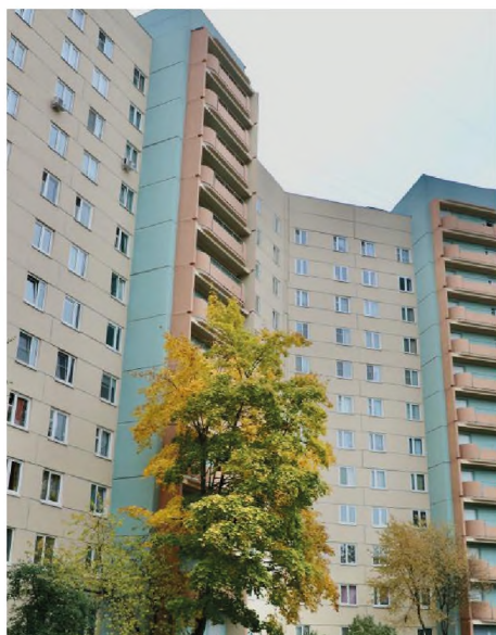
ремонт фасада многоквартирного дома на пр. Энтузиастов, д. 54, к. 1, лит. А
