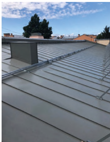
ремонт крыши многоквартирного дома на Конторской ул., д. 12, лит. А
