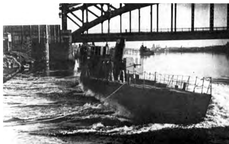
⤴ Спуск на воду первого 100-тонника, построенного на Петрозаводе
