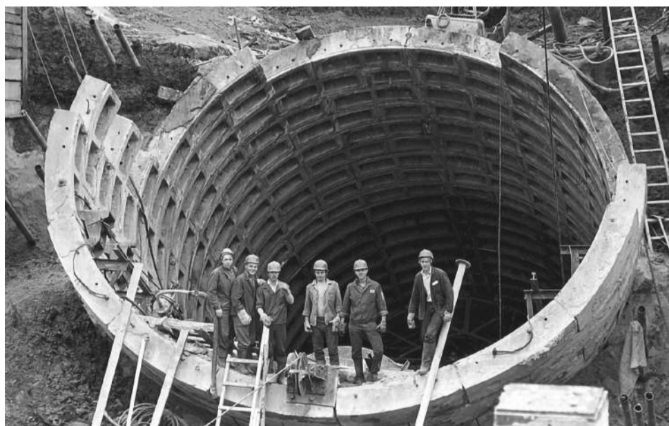
Метро Новочеркасская, строительство, 1949 г.
